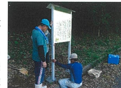
案内板の設置工事
