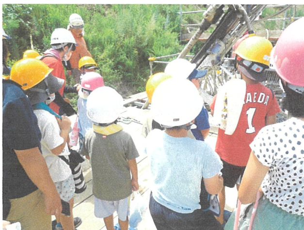
アンカー工法の様子
