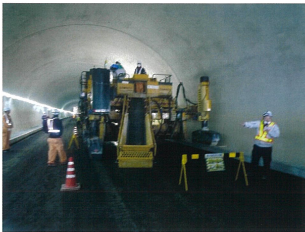
ICT 施工コンクリート舗装機による 舗装の様子
