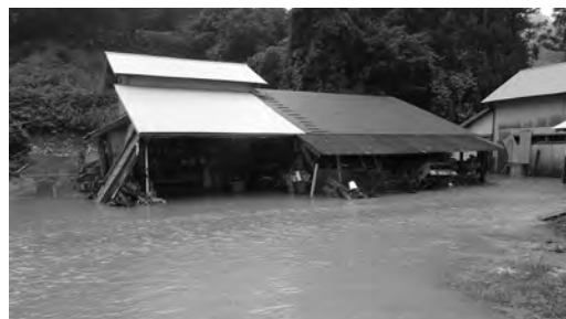
▲集中豪雨により浸水した倉庫 (温泉津町福田地区)
