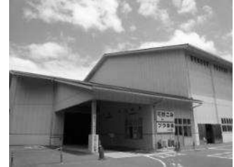
可燃物中間処理施設
