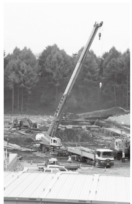
▲建設中の諏訪湖周クリーンセンター
