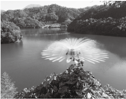
▼三瓶ダムに設置してある噴水(水質保全設備)
