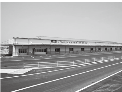
▲和江港整備工事により平成25年8月に完成したJFしまね大田水産物地方卸売市場
