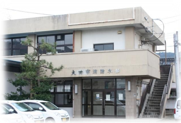
旧大田市消防本部・消防署庁舎
