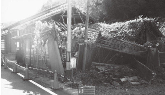
▲解体撤去工事された大森町地内の危険家屋
