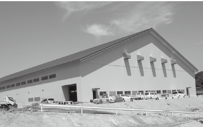
▲仁摩町宅野に建設中の新不燃物処理場
