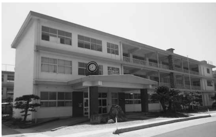
▲平成26年度に温泉津中、仁摩中の2校統合により開校した「大田西中学校」
