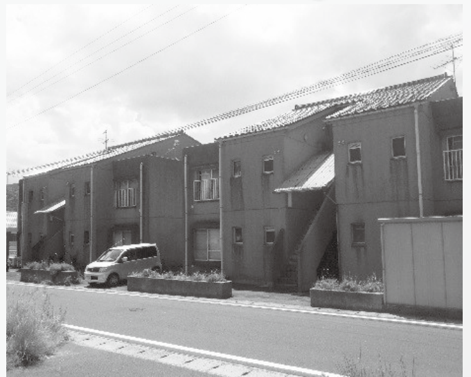
公共住宅修繕事業 (市営高禅寺住宅改修)
