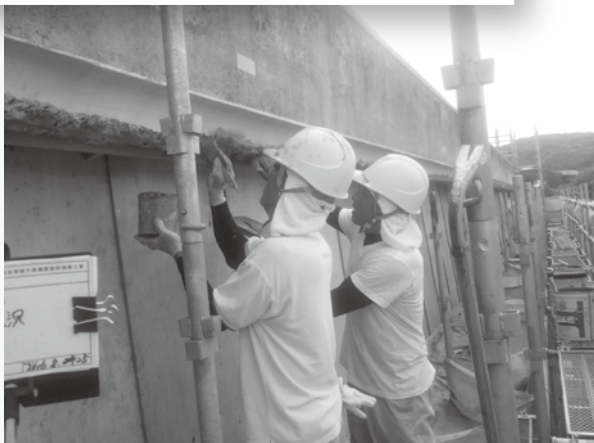
鳥井小学校体育館外壁コンクリート補修工事業
