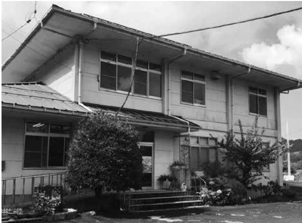
▶老朽化している富山まちづくりセンター
