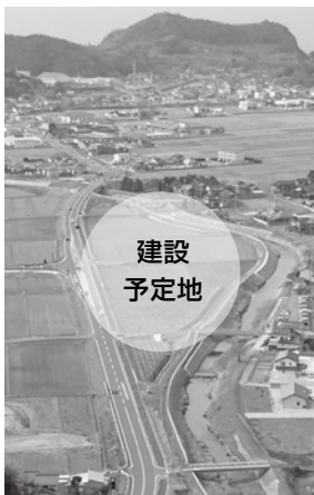
▶仁摩道の駅建設予定地(仁摩町)
