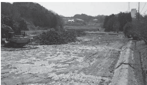
▲土地基盤整備工事が進められている（波根地区）
