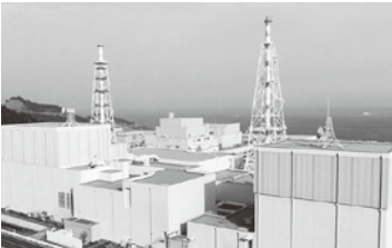
▶ 島根原子力発電所
