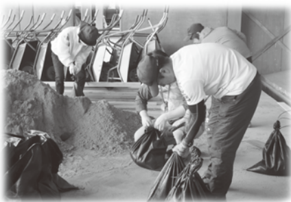
▶屋根瓦を補修するためのブルーシート用土嚢づくり
