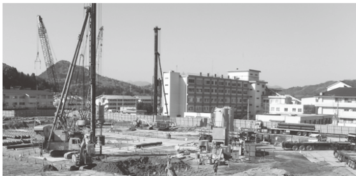
新大田市立病院 杭打設工事(H30.4月)
