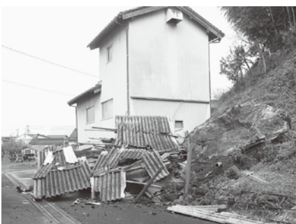
▲地震によるがけ崩れで被災した倉庫
