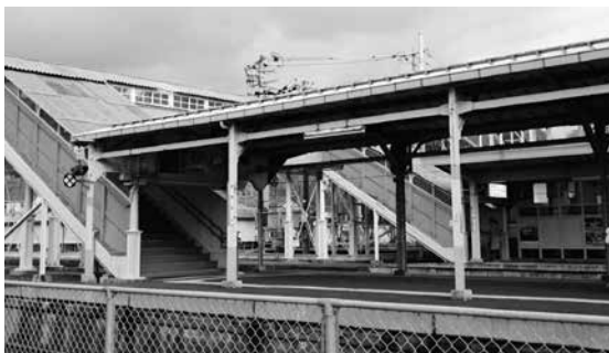
▶大田市駅のホームをつなぐ陸橋
