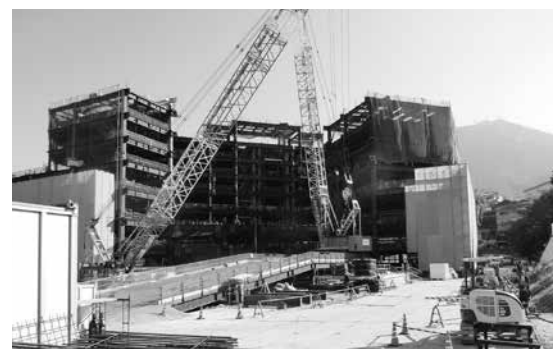
▲建設中の新北九州市立八幡病院
