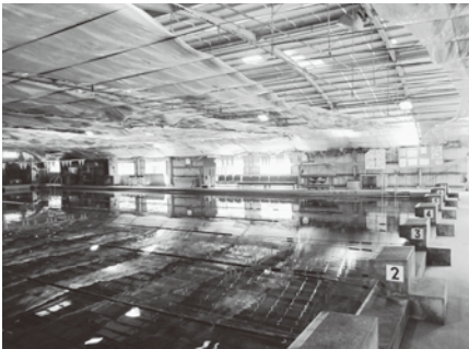
▶ 解体された五十猛温水プール
