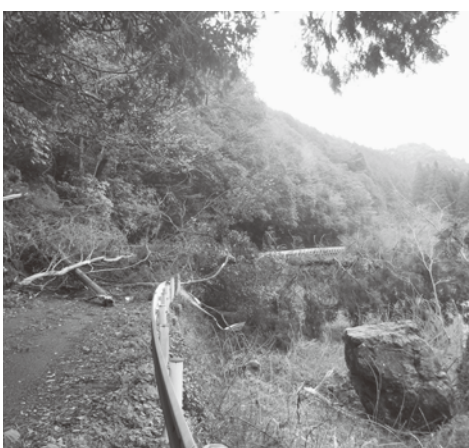
▲ 4月9日島根県西部地震時の被災道路
