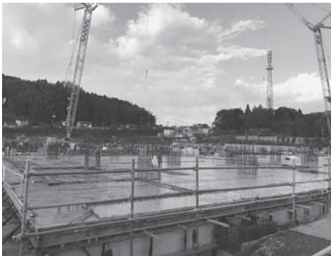
▲新大田市立病院建設工事現場（11月）
