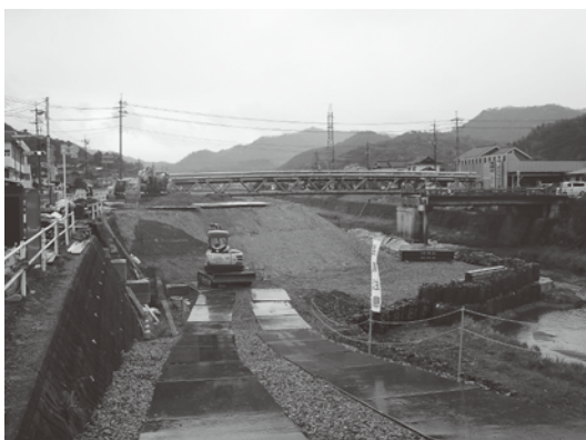
街路整備事業(菜洗橋の架け替え工事) 2億9,420万円
