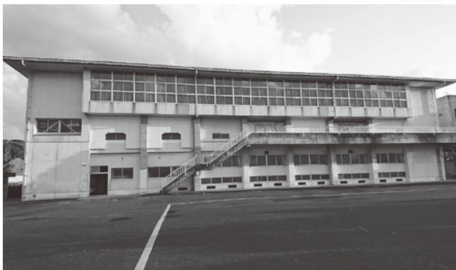
第二中学校屋体の大規模改修工事 1億6,870万円
