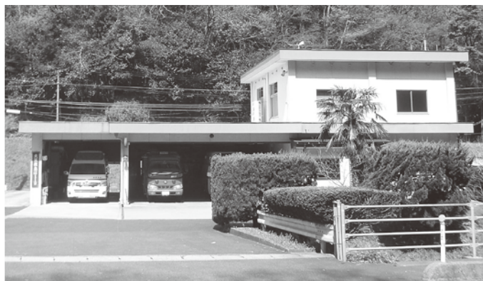
西部消防署庁舎新築整備事業 1億7,100万円
