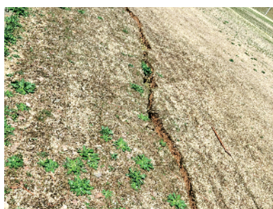
志学小中学校校庭亀裂
