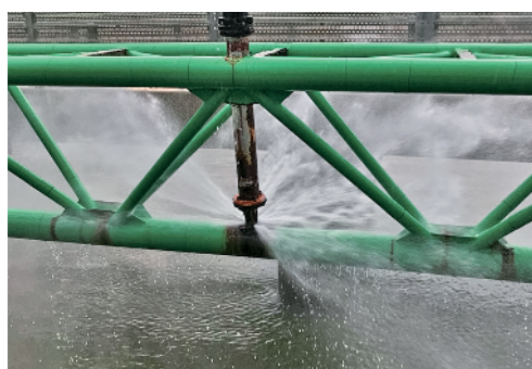
鋼管φ200（水管橋）空気弁接合部破損 作業断水による断水件数625戸
