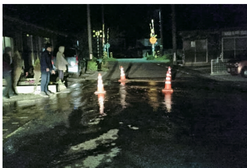
配水管ACPφ150漏水 作業断水による断水件数323戸
