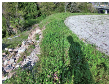
田被害（三瓶町多根地内）
