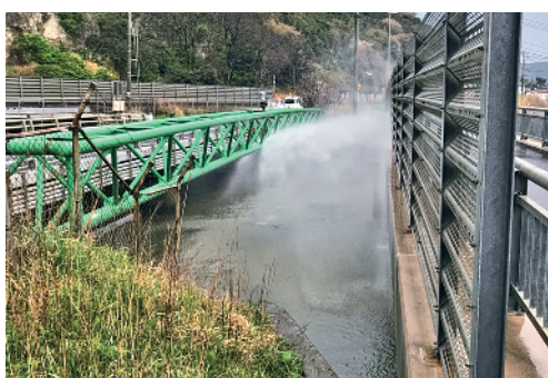
鋼管φ200（水管橋）空気弁接合部破損 作業断水による断水件数625戸
