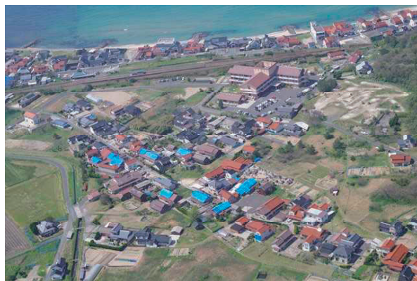
ブルーシートのかかった屋根等 (波根町大津地区・H30. 4. 18撮影)
