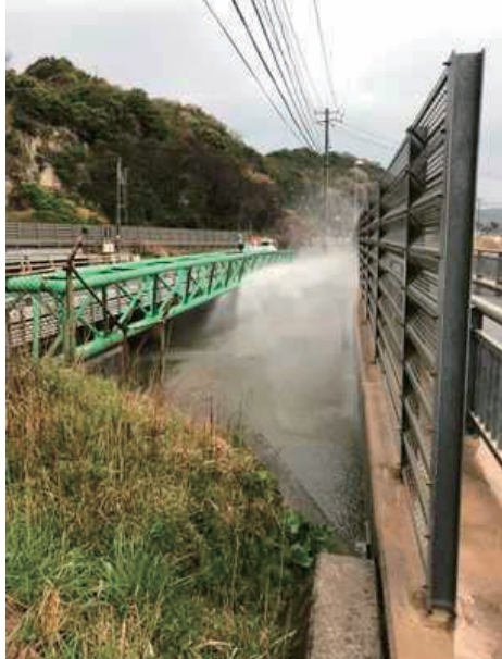
掛戸橋水管橋（大田市波根町）
