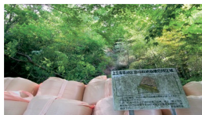
（落石対策施工箇所）
