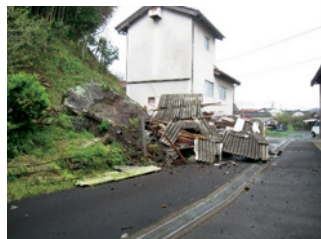
（落石による被害状況）
