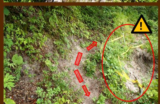
斜面が崩落し、道が狭くなっています。また悪天候時には斜面崩落の恐れがあります。
