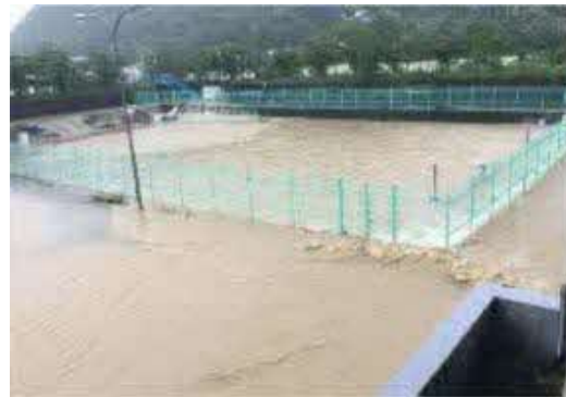
浄水場の冠水状況（広島県）
