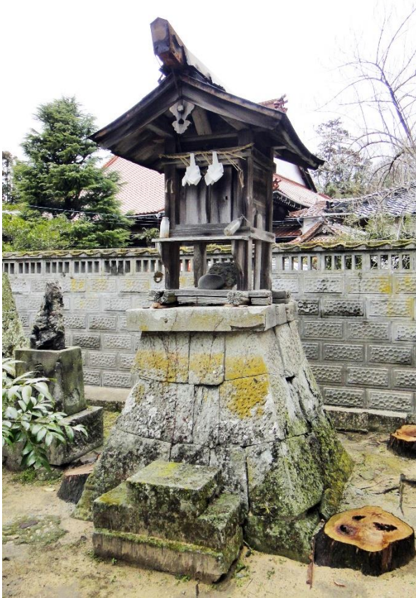
祠 最大幅 125 / 奥行き最大 115 台石 (石組) 最大幅 141 / 奥行最大 135
