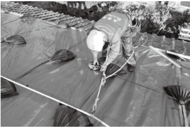
▲ボランティアセンターによるブルーシートの張替え作業
