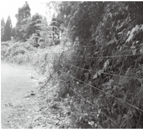
▲被害にあった防護柵
