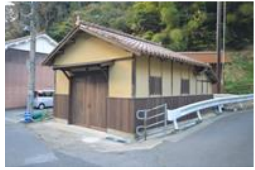
消防資機材庫修景 【後】
