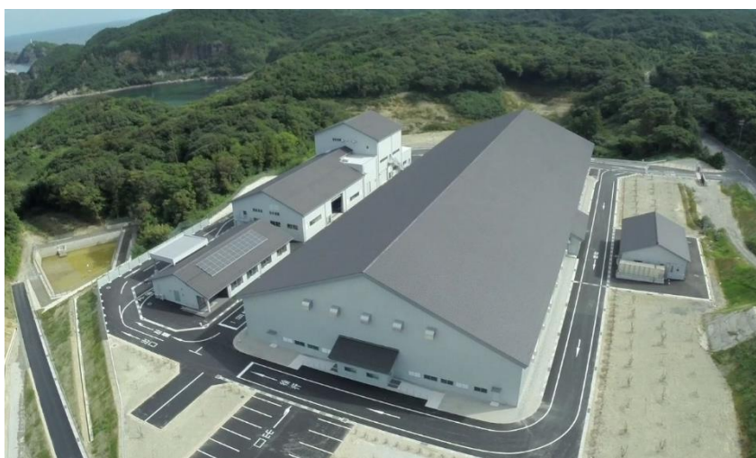
大田市不燃物処分場
