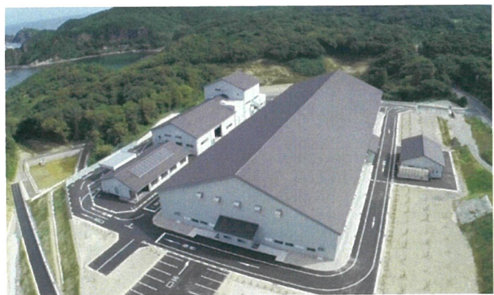
大田市不燃物処分場
