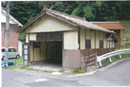
消防資機材庫修景 【前】
