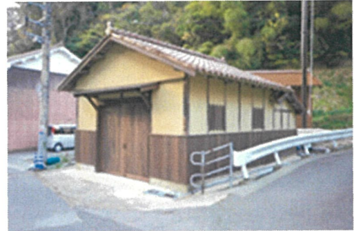
消防資機材庫修景 【後】
