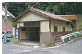
消防資機材庫修景【前】
