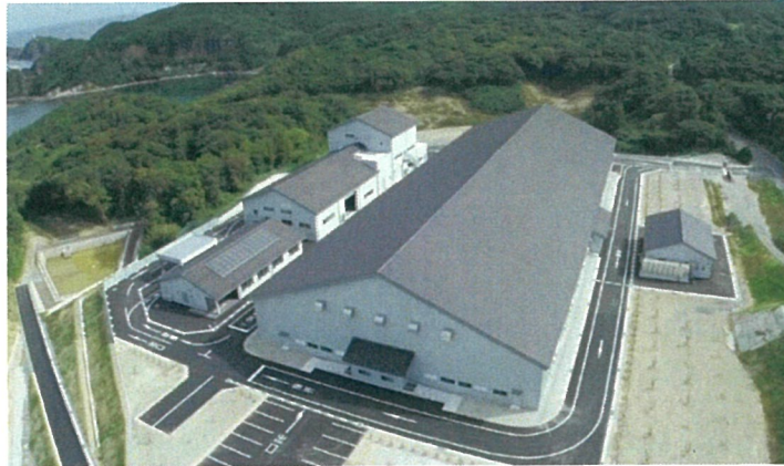
大田市不燃物処分場
