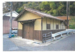
消防資機材庫修景【後】
