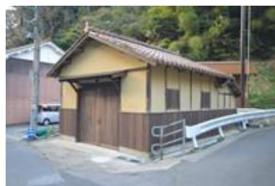
消防資機材庫【修景後】
