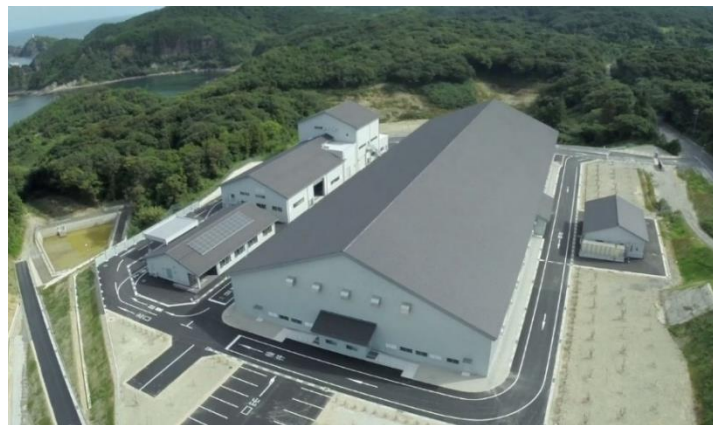
大田市不燃物処分場
