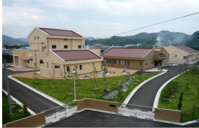
公共下水道大田処理区 大田浄化センター
