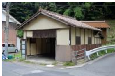
消防資機材庫【修景前】
