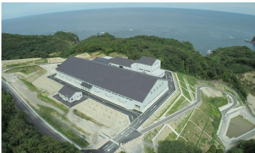
大田市不燃物処分場
