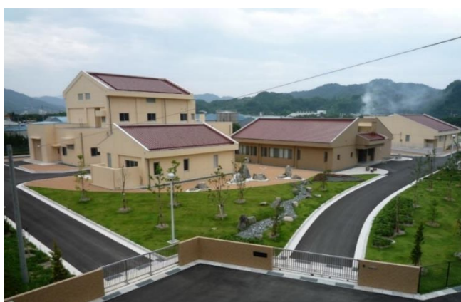
公共下水道大田処理区 大田浄化センター
