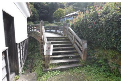
銀蔵小路橋【修景前】
