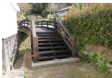
銀蔵小路橋【修景後】
