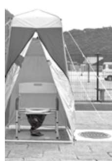
▶道の駅いせ仁摩に整備されたマンホールトイレ
