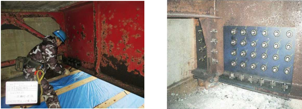
写真4-1 当て板工実施状況
