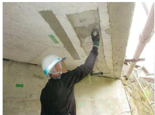
写真4-3 断面修復状況
