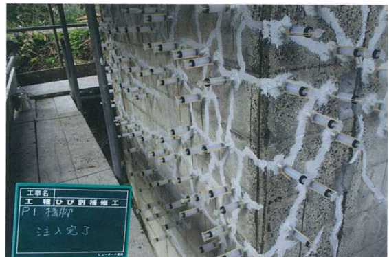
写真4-2 ひび割れ注入状況
