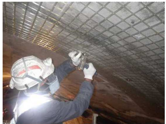
写真 3 - 1 FRP ネット設置状況 ※出典：島根県道路トンネル修繕計画(H28.3)
