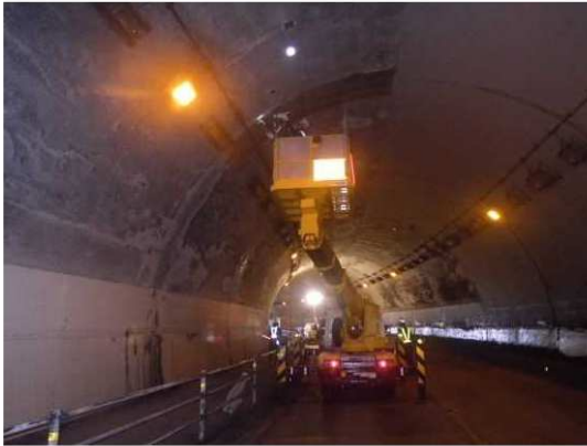
写真 3 - 1 FRP ネット設置状況 ※出典：島根県道路トンネル修繕計画(H28.3)
