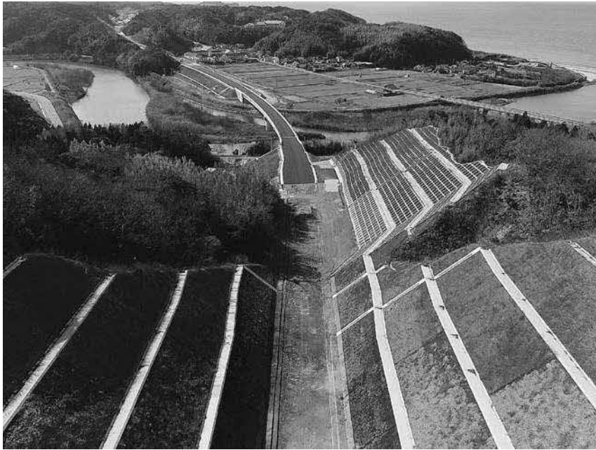
建設が進む「大田・静間道路」 静間川橋付近
