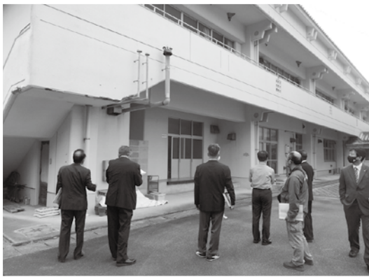
▲五十猛小学校(塩害による劣化を確認)
