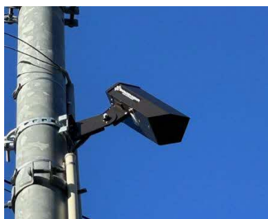
設置する積雪深センサー
