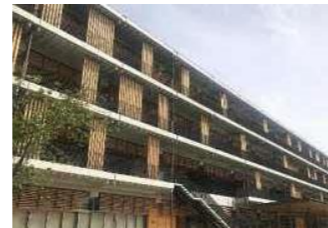
日射遮蔽ルーバー (日向市庁舎)
