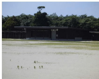
多目的広場管理棟
