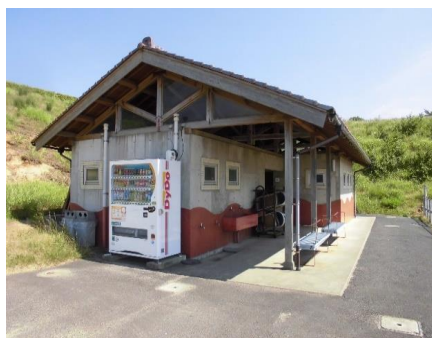
駐車場トイレ
