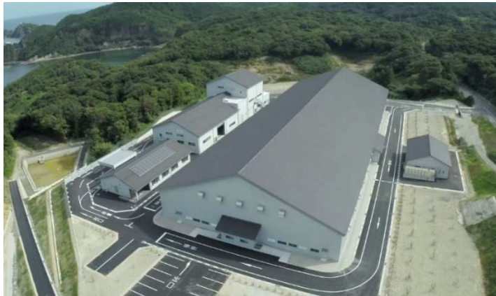
大田市不燃物処分場
