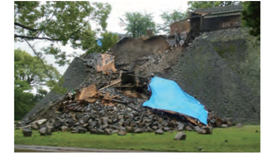
2016年 (平成28年) 「熊本地震」 熊本城の被災状況
