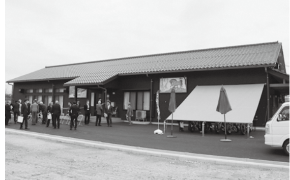
新たに竣工した馬路まちづくりセンター
