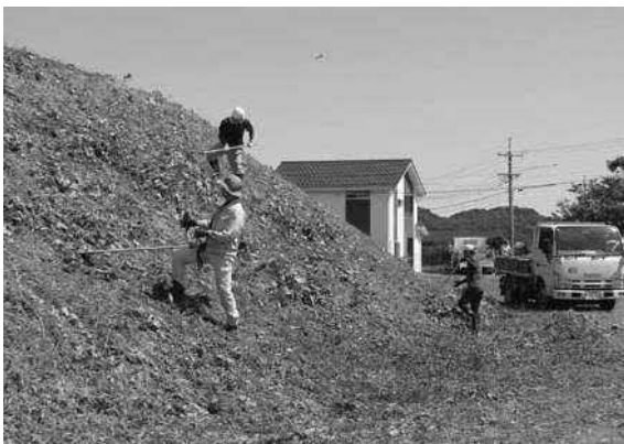
広範囲の作業でしたが 手際よく進められました
