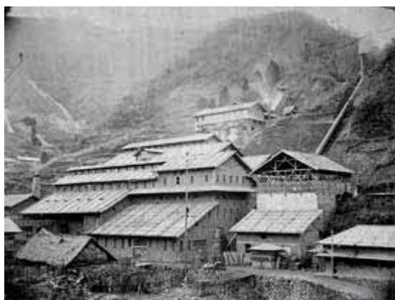
稼働中の清水谷製錬所
