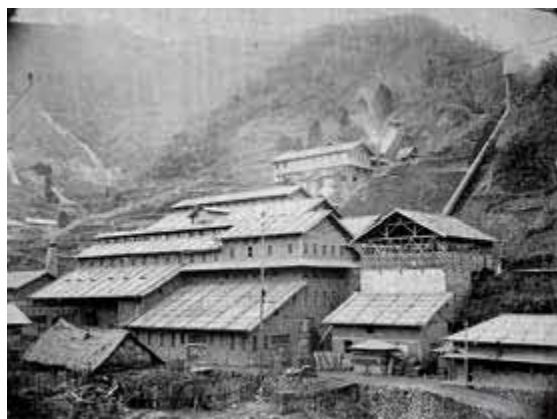
稼働中の清水谷製錬所
