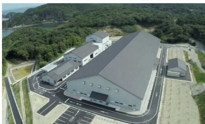
大田市不燃物処分場
