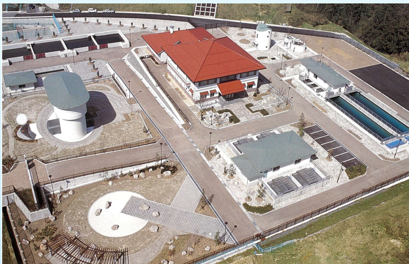
三瓶浄水場(大田町野城) 水源 三瓶ダム 急速ろ過 7,500m 3 /日 敷地面積 19,600m 2
