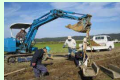
コンクリート水路の更新
