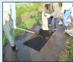
農道の部分補修
