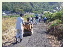
未舗装農道の舗装
