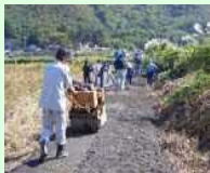
未舗装農道の舗装
