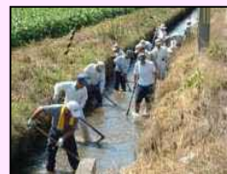
水路の泥上げ
