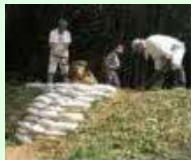
漏水箇所の補修
