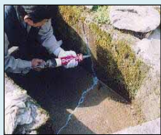
ひび割れの補修
