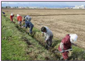
水路の泥上げ
