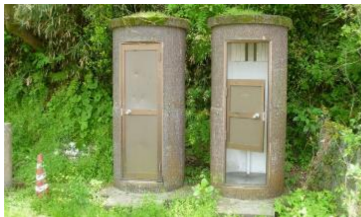
※R5年度にトイレ解体
