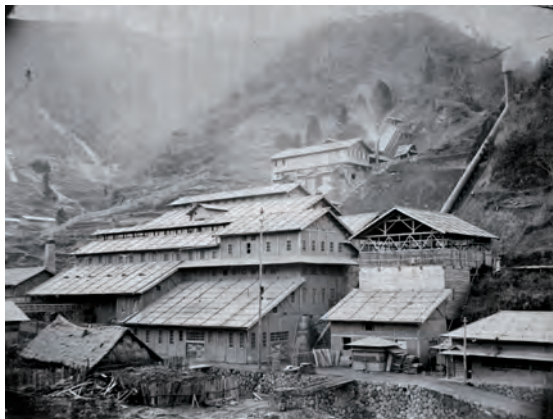
稼働中の清水谷製錬所
