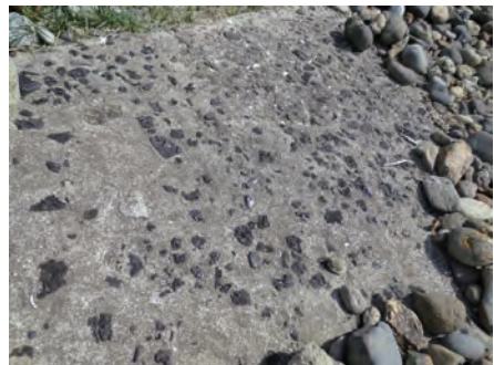
製鉄で出た鉄滓を再利用した防波堤
